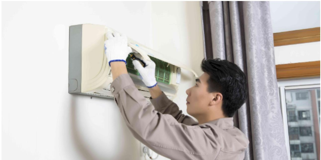
各种家用空调器的电器控制板的布置形式及选用的方法不尽相同，功能的设置有多有少，但是操作方法根本相同。应当熟悉空调器的各种功能及使用，以便正确掌握空调器开机和停机方法。无论是手动开关或是遥控器操作，空调器的开机操作根本如下：根据空调要求和使用要求，挑选空调的工作方法，如制冷、制热、除湿或通风等。这只要按空调器上的工作方法挑选键挑选。设定温度，调节温度调节器的温度值。一般制冷工作时，温度值设定范围在20–30℃。制热工作时，温度值设定范围在14–27℃，所设定的温度值是指空调器的回风温度或房间温度。为了查验压缩机是否能工作，制冷时设定值应低于其时室内温度，制热时应高于其时室内温度。这样空调器开机后，就能判断压缩机是否能正常工作。空调清洗不复杂，打开空调盖，将裸露在外部的机壳用湿抹布擦拭，清洗时需要注意容易附着灰尘的通风口。内蒙古空调清理流程
